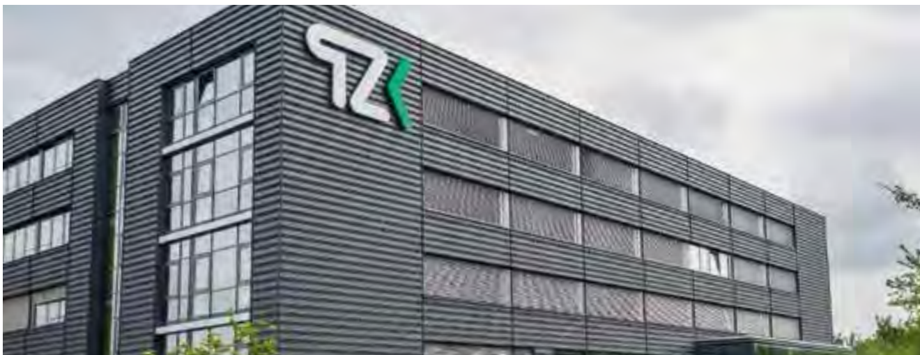
Das moderne TZK-Gebäude steht in Nachbarschaft der Universität.
