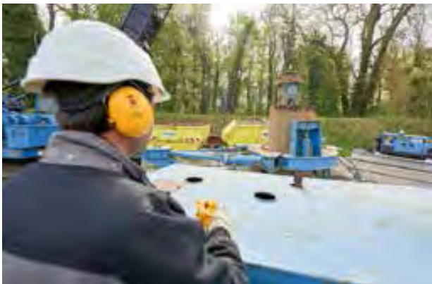
Ein Spezialbohrer arbeitet sich auf dem Oberwerth insgesamt 14 Meter in die Tiefe des Neuwieder Beckens.
