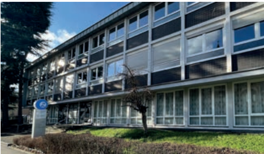
Das Schulgebäude in der Mainzer Straße wurde 1959 bezogen.
