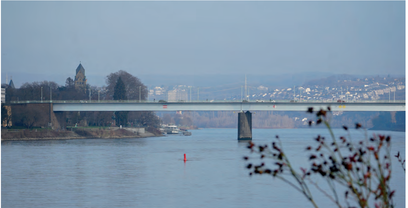
Der Neubau der Pfaffendorfer Brücke ist eines der größten Infrastrukturprojekte im Land.
